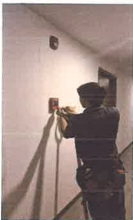
ภาพการทดสอบ Manula Pull Station
