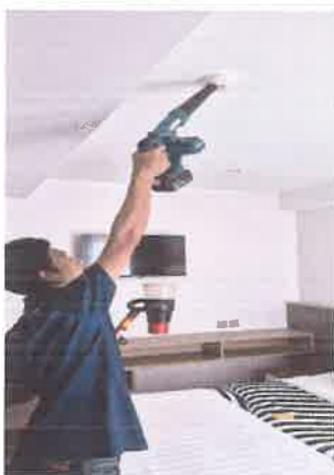
ภาพการทดสอบ Smoke Detector
