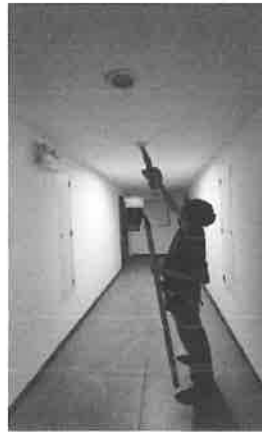
ภาพการทดสอบ Smoke Detector
