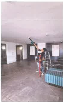
ภาพการทดสอบ Smoke Detector
