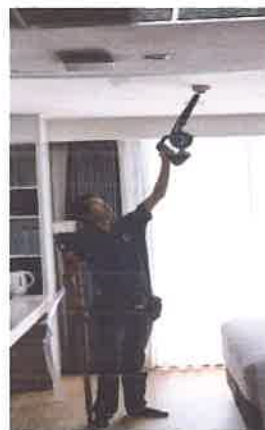
ภาพการทดสอบ Smoke Detector
